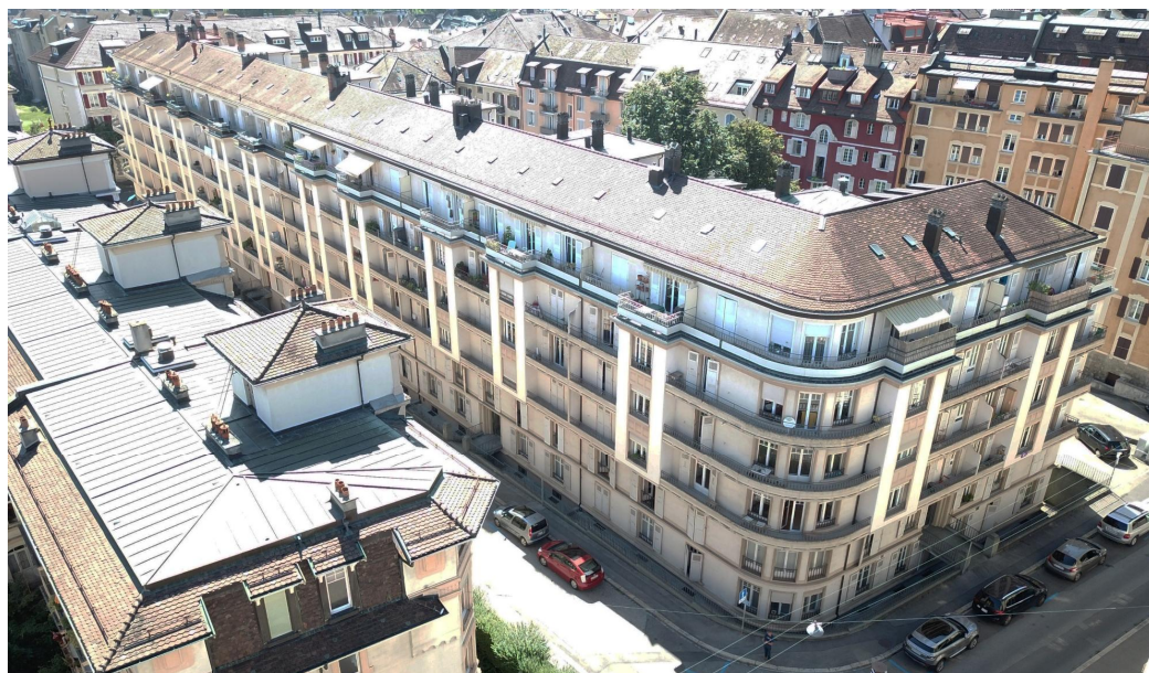
Photo de la toiture existante
